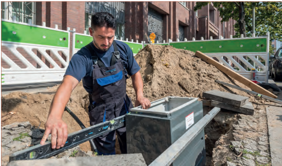
Abb. 1 Bei den Tiefbauarbeiten für Ladesäulen kommt es auf zentimetergenaue Präzision an
