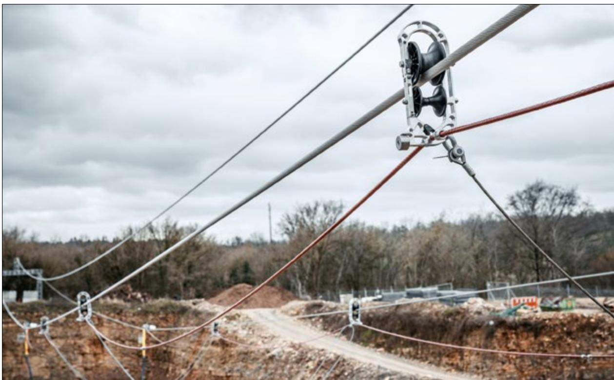
*Das OSS-Rollenleinsystem gewährleistet beim Seilzug einen zuverlässigen Kreuzungsschutz*
